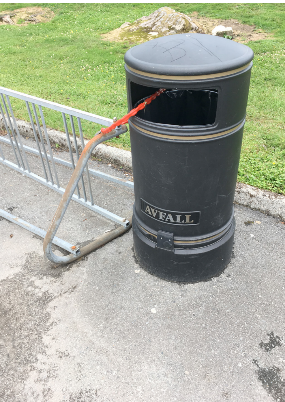
Både sykkelstativ og avfallsbeholder er montert til bakken
